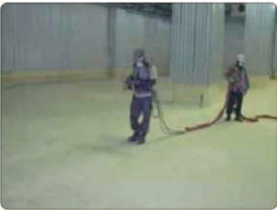
냉동창고 벽면·바닥 스프레이 시공
