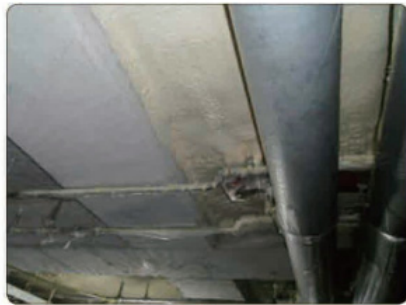
일반 건축물 천정부 스프레이 시공
